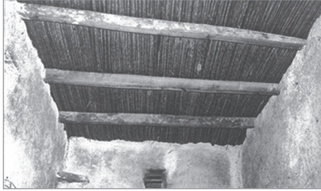
الشكل (٣) حصيرة من جريد النخيل في سقف مسكن عرايشي.
